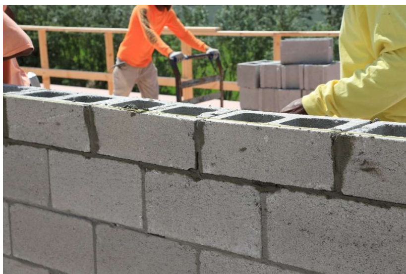
Figura 08: Bloco de concreto sendo instalado na obra
