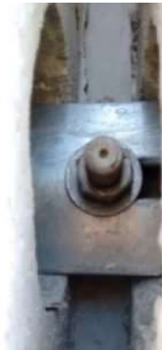
Figura 04: Processo de fixação entre dois painéis pré-fabricados alveolares.
