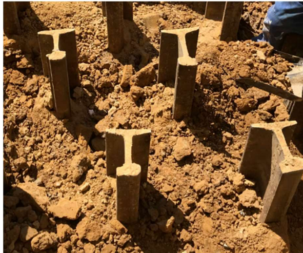
Figura 02: Bloco de estacas metálicas tipo trilho
