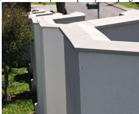
Figura 22: Ilustração da aplicação da pingadeira
